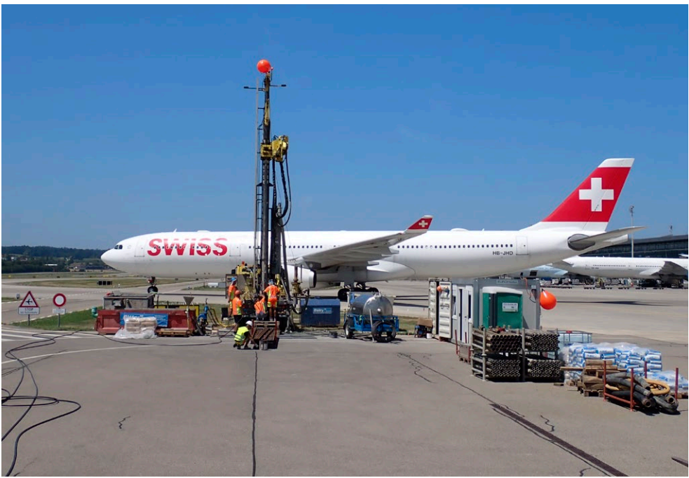
Die Sondierbohrungen am Flughafen Zürich waren erfolgreich. Nun folgt die Erstellung eines Testbrunnens. © Geo Explorers
