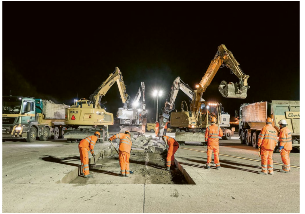
Eifriges Treiben während der nächtlichen Sanierungsarbeiten an der Piste 14/32 im Jahr 2014.
